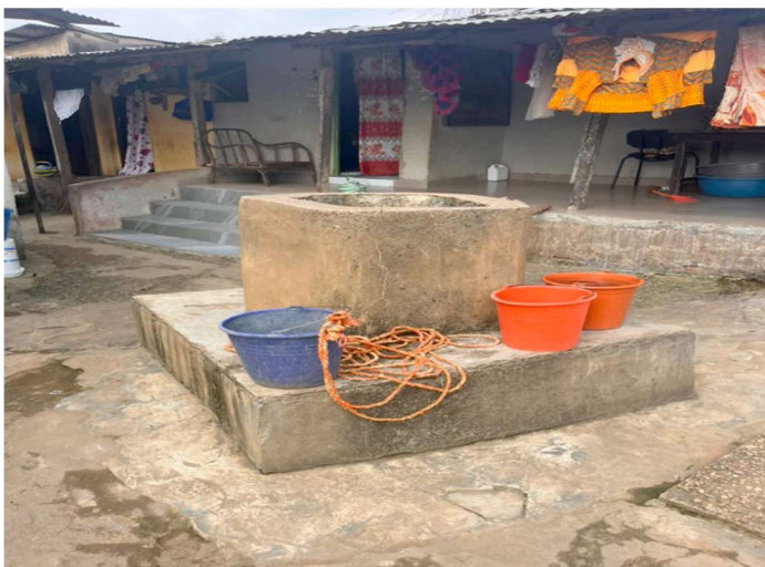
Photo3 : un puits non couvert dans le quartier Gbagba-extension, cliché auteur, 2022
