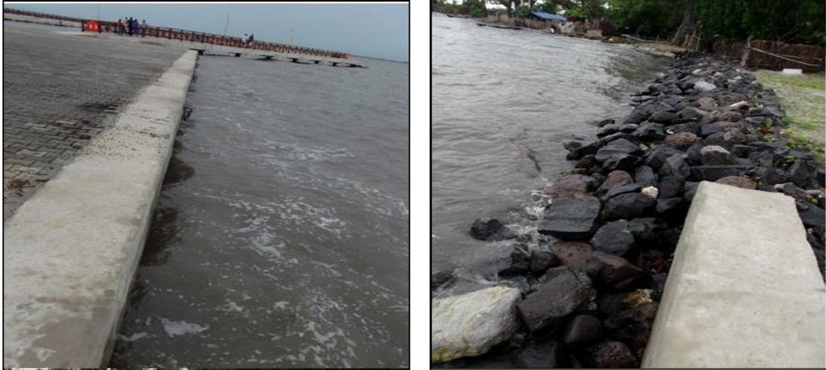
Image 1: Mur de protection contre l'érosion côtière à Carabane
