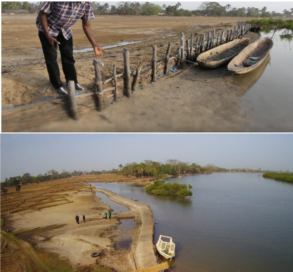
Image 8: Exemple de digue artisanale (en haut : digue construite un peu plus loin de la plage, en bas : juste à proximité des bolongs)
