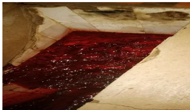
Photo 4 : le bassin de rétention du sang de l'abattoir Frigorifique de Sabalibougou
