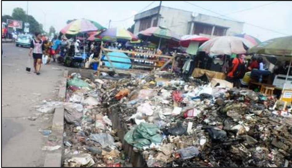
Photo 1 : Un caniveau obstrué d'ordures au marché Total
